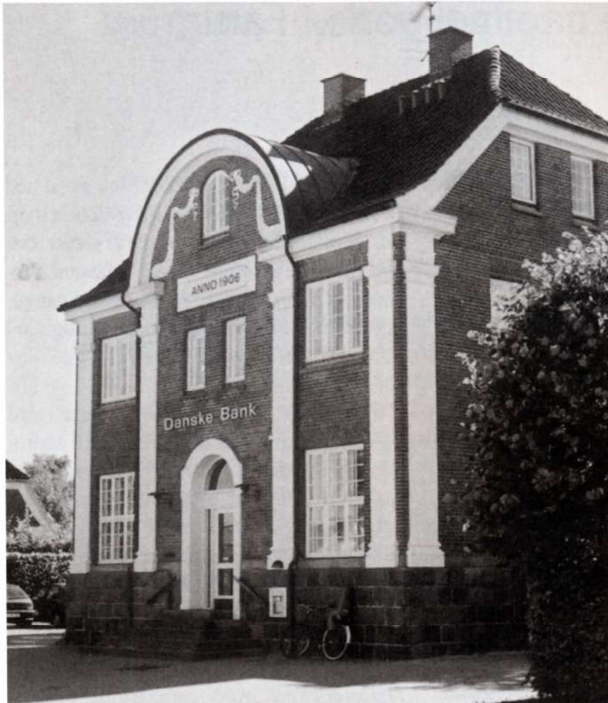
Bankbygningen fra 1906 på Farum Hovedgade. Oprindeligt blev den opført som A/S Slangstrupbanens Oplands Bank. I dag er der Danske Bank. (Farums Arkiver og Museer)
