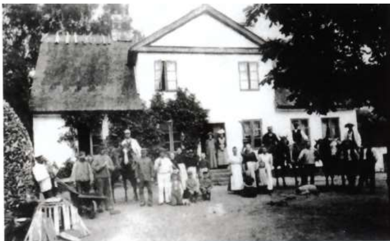
Hovedbygningen til Petershvile som den så ud i 1901, mange år efter Jens Nielsens død. Familie og tjenestefolk - 21 voksne, seks børn, seks heste og en hund på billedet. Petershvile er et af teglværker der stadig er på Sjælland. Der har været teglværk siden 1924. Gribskov Lokalarkiv.
