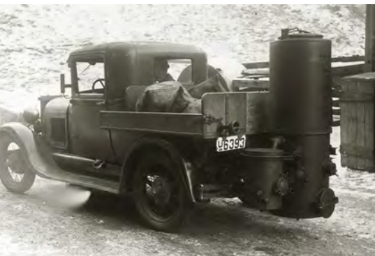
Gasgeneratoren betød at man kunne udnytte den gas, der er i træet, når det brænder og dermed erstatte den sparsomt tildelte benzin. Det kostede til gengæld ganske store skovområder. Fotograf fra ca. 1942. Kolding Stadsarkiv.
