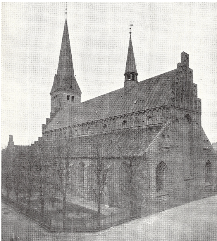
St. Olais sydside og østgavl 1898, fotograferet umiddelbart efter opsætningen af det nuværende spir. Gavlen har smukke kamtakker og blændinger. Det store østvindue, bag hvilket altertavlen står, er tilmuret. Langs søndre sideskibsmur står en række støttepiller; mellem disse ses flere gravkældervinduer. I fag 2 skimtes den i teksten omtalte sandstensportal. – Foto, optaget på foranledning af tømrerm. Wilh. Unmack, der opførte spiret; skænket til Helsingør Bymuseum af overlæge C. U. Jessen, Helsingør.
