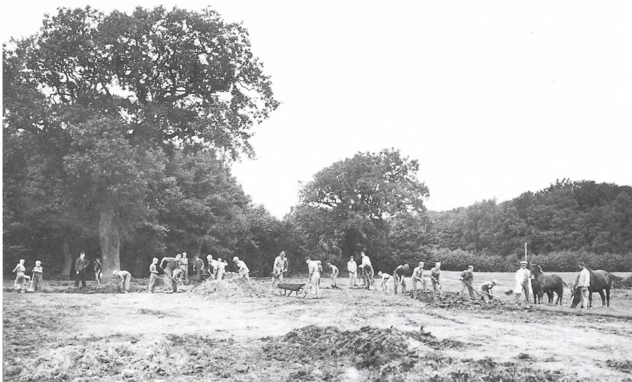
Udfyldning og Planering ved de store Ege.
