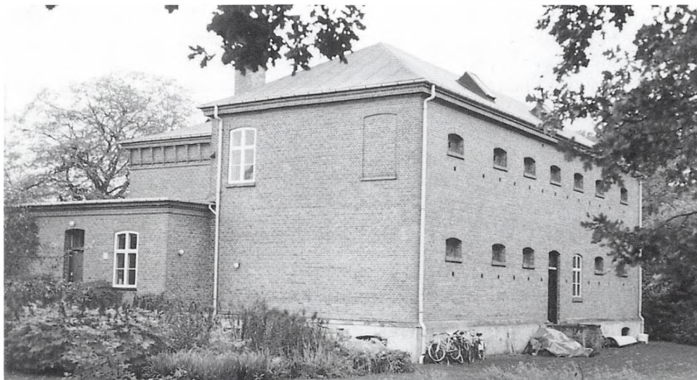
Bagsiden af ting- og arresthuset med cellevinduer. Kronborg østre Birk. Foto: Steen Bernichow
